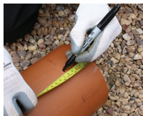
Mandzstta fél szélességét a másik csőre felmérni
