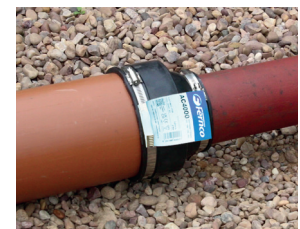
Bilincseket az előírt nyomatékkal meghúzni
