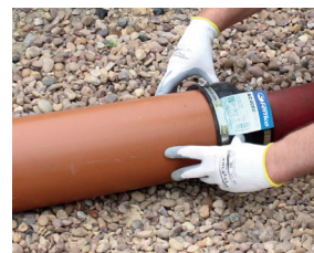
Csőveket összetolni, a mandzsettát jelölésig csúsztatni
