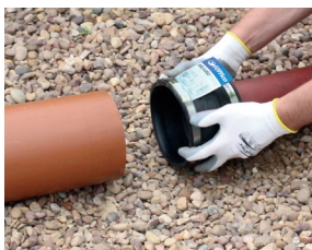
Bilincset megoldani, az egyik csőre felhúzni
